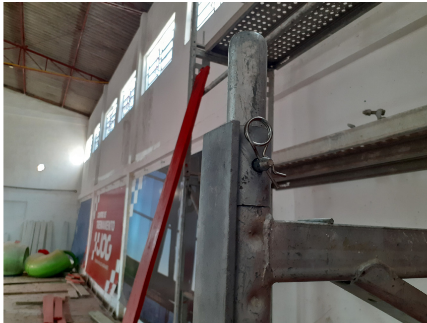
Encaixe do pino e trava pino
